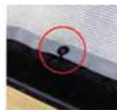
E' provvista di bottoni antivento che rendono la rete più resistente contro le uscite fuori sede
